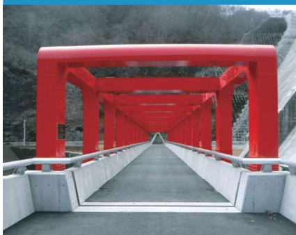
橋梁 床版・壁高欄
