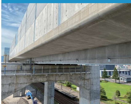
橋梁 張出床版
