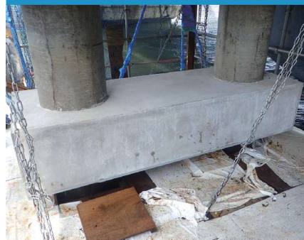
橋脚 耐震補強
