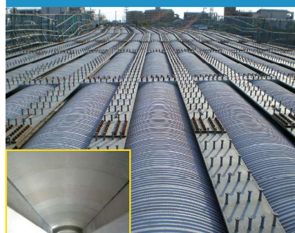
橋梁 プレベーム桁 床版
