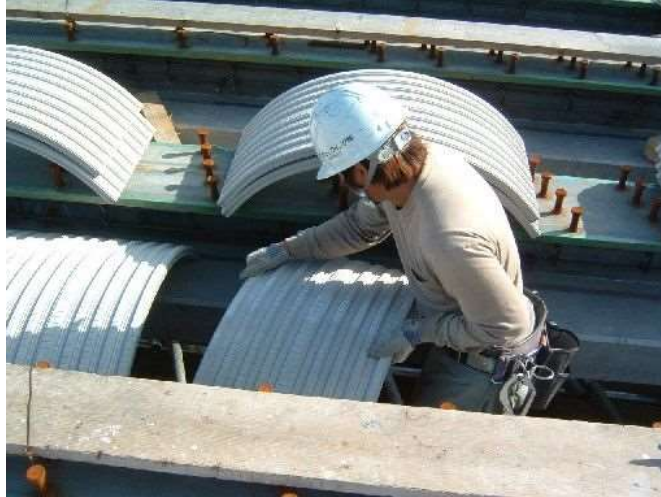
KKアーチフォームの組立状況
