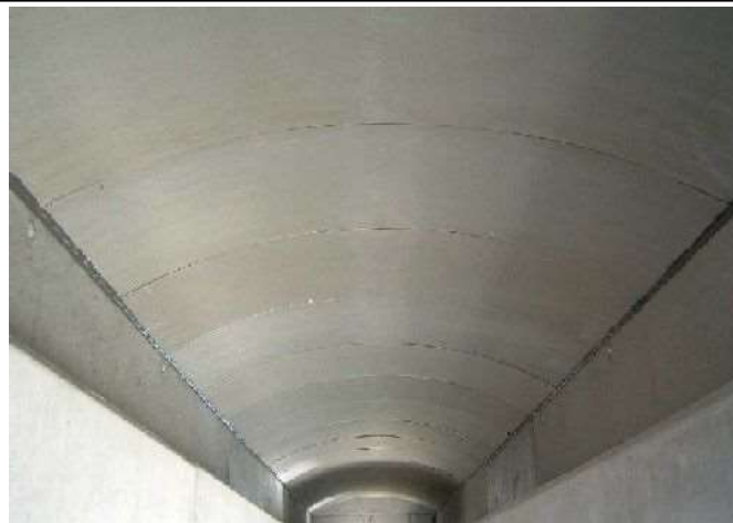
RC床版の下面仕上り状況
