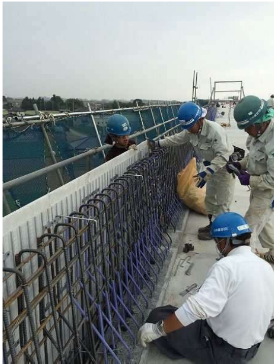
埋設型枠の組立て(その1)
