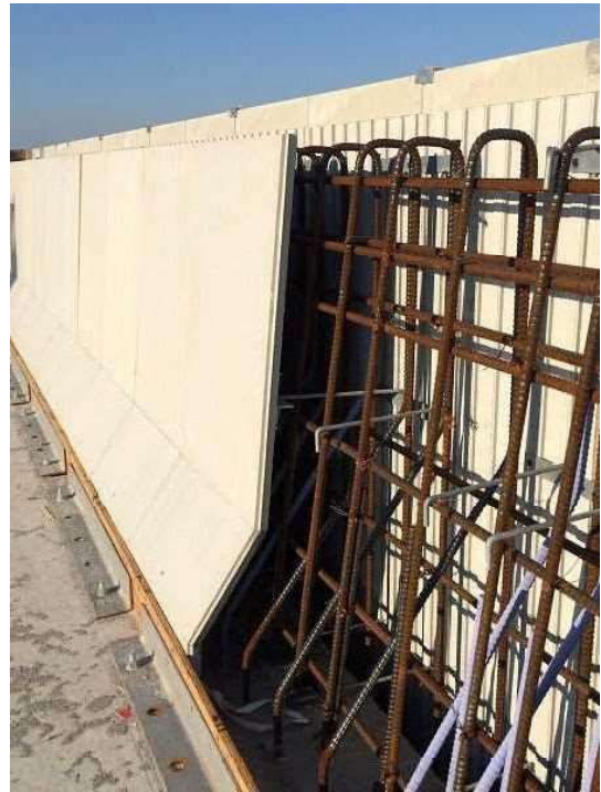
埋設型枠の組立て(その2)
