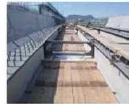
簡易足場の施工例
