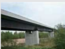
道東自動車道（平成11年）外側
