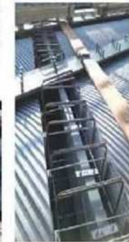
横桁の施工例
