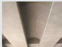
中間床版への適用事例
