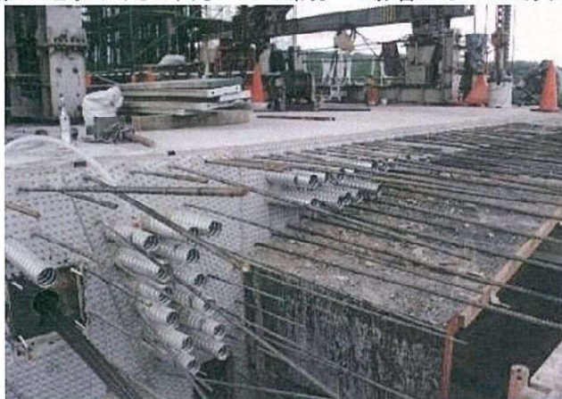
打ち継ぎ目の施工状況
