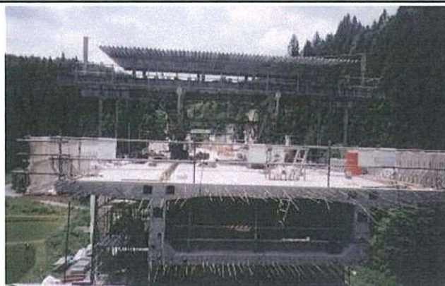
箱桁橋での施工例
