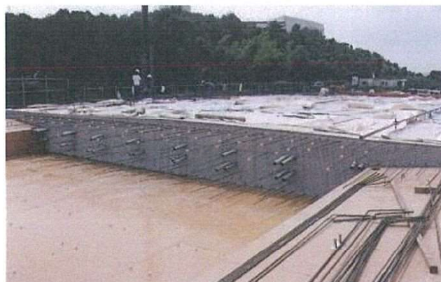
中空床版橋での施工例
