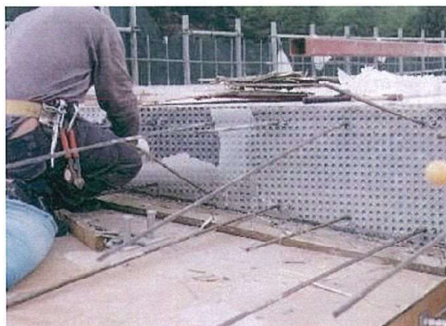
シートの取り剥がし状況
