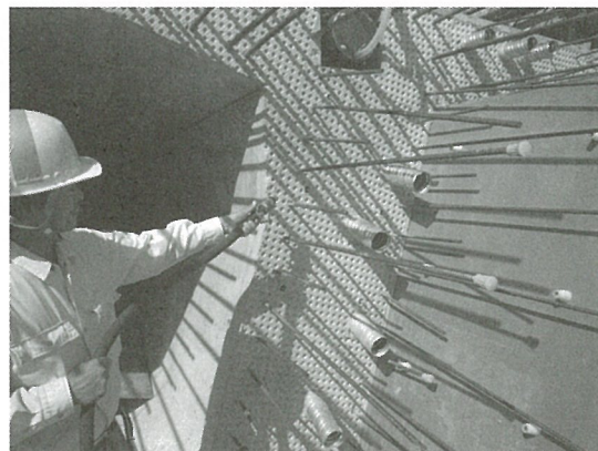
写真－5 打継面の清掃状況
