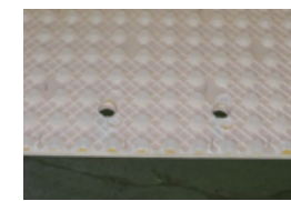
貫通孔の施工例
