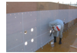
型枠への貼りつけ
