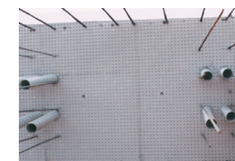
打継目の状況
