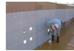
型枠への貼りつけ
