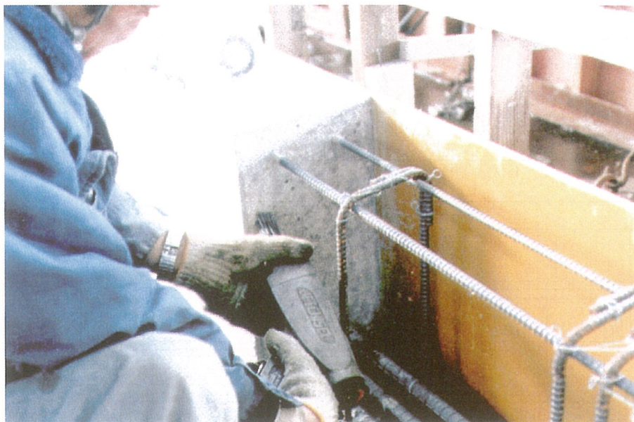
写真Ⅱ-10 チッピングの打継ぎ処理面の状況
