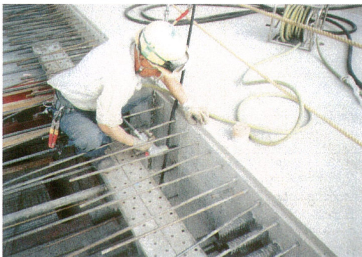
写真Ⅱ-20 チッピングの作業状況（E橋梁）
