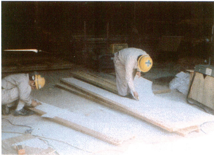
写真Ⅱ-15 切断作業の状況
