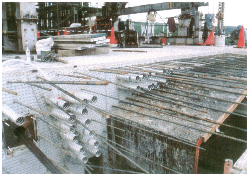
写真Ⅱ－1 KKシートによる打継目の施工（橋梁）
