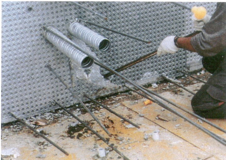
写真Ⅱ-19 過密配筋部での取り剥がし作業状況
