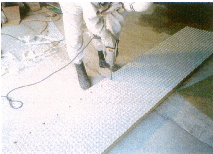
写真Ⅱ-16 穿孔作業の状況
