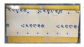
③鉄筋孔の周囲には4箇所でタッカー留めする。 コンクリートノロがKKシート背面にまわらないように ノロ止めシールとKKシートを密着させる。
